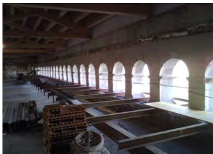
Obras del antiguo hospital de Santa Caterina (Girona)
